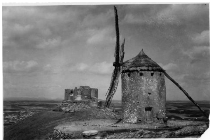
Fig. 3. Molino en el Cerro Calderico (Consuegra) con cubierta de madera.1920 Fondo Rodríguez (Archivo Histórico Provincial de Toledo)
